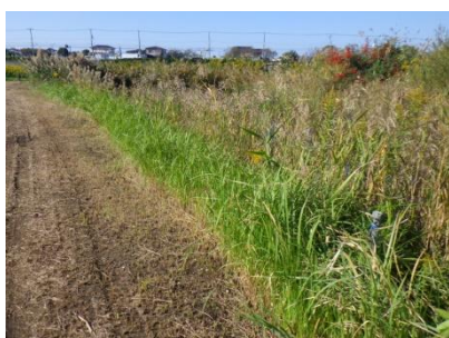
3 - ①池法面 観察可能化除草
