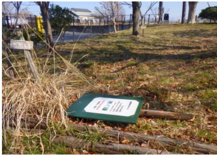
木製杭 腐食 杭交換設置後 250309
