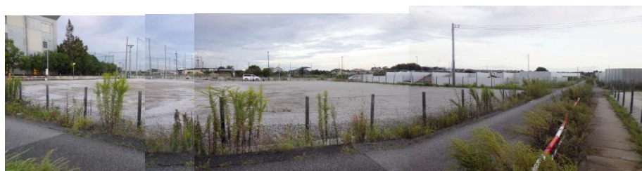
241004 広域整備 環境完全消失
